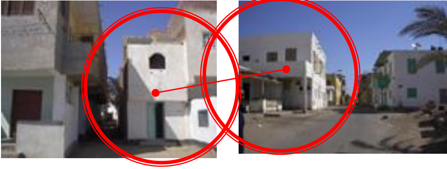
شكل ٥: عملية بناء وترميم لبعض المباني تتم بغير مراقبة.
